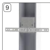
9 Elementy wzmacniające konstrukcję ościeżnicy
