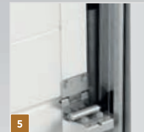
Układ sprężyn naciągowych
