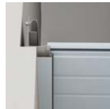
Montaż za otworem - maskownica za otworem
